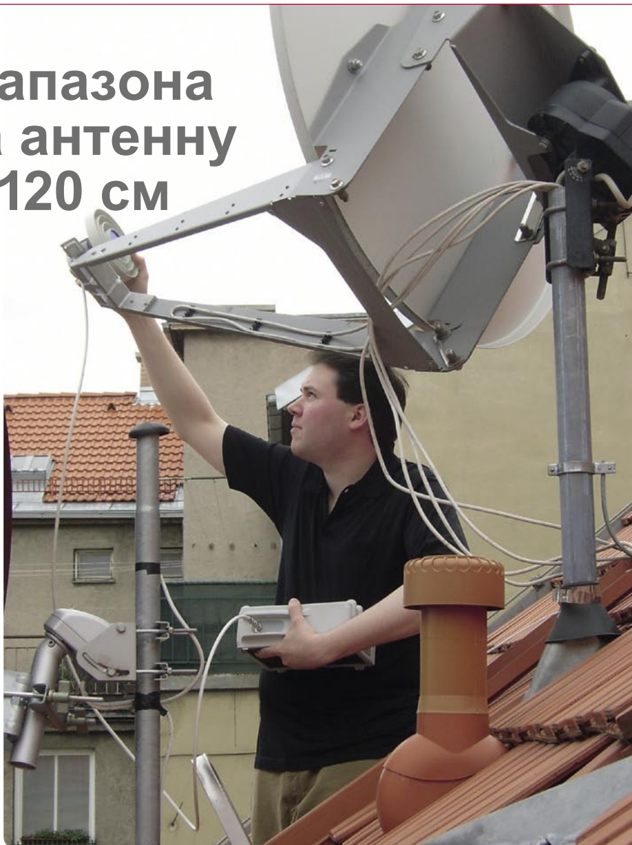
Томас Харинг настраивает облучатель С-диапазона на антенне диаметром 1.2м, измеряя полученный сигнал спектроанализатором Prodig-5, также представленном в этом номере |
