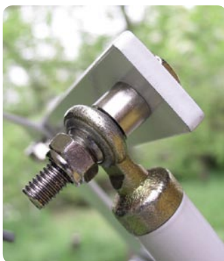
Соединение выполнено в виде опоры давления
